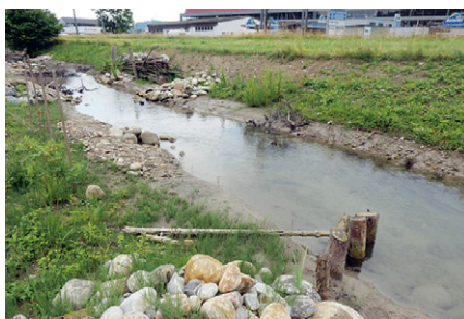
Rosshänggibach vor und nach der Revitalisierung
