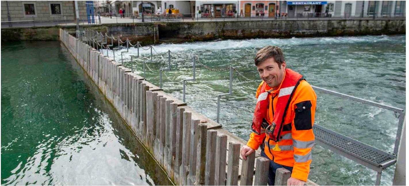
Dani Arnold inspiziert das Reusswehr in der Stadt Luzern. Die langen Holzteile werden als Nadeln bezeichnet.
