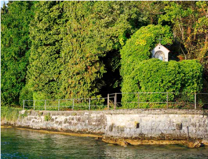
Eine künstliche Ufergestaltung zeichnet sich zum Beispiel durch eine steile eintönige Ufermauer ohne natürlichen Übergang zwischen Wasser und Land aus. Die Mauer bildet eine Barriere.
